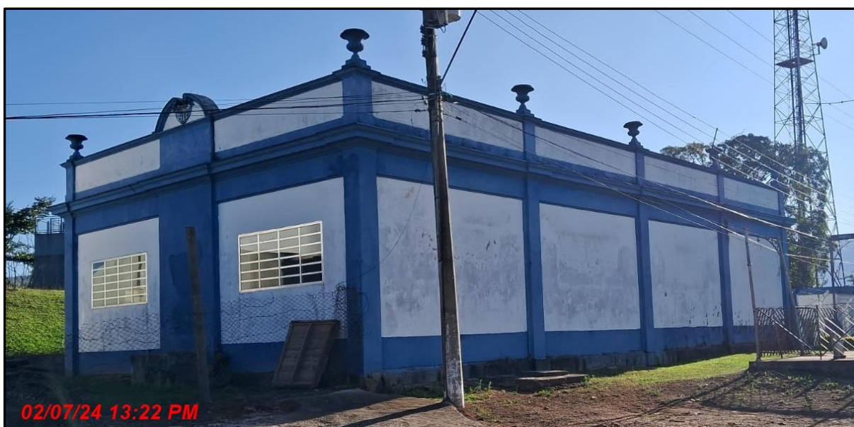
Foto 03. Vista atual do Reservatório a partir do logradouro.
