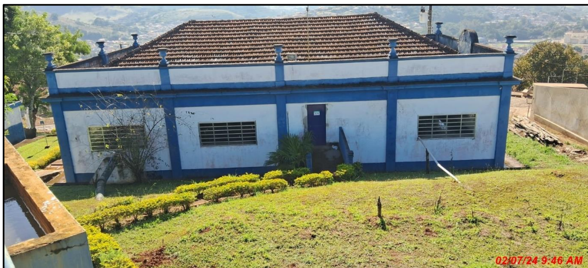
Foto 02. Vista atual do Reservatório a partir da ETA.
