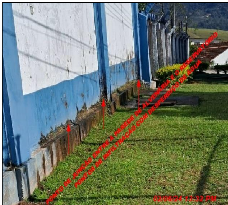
Foto 08, junção da parede com piso lado externo da ETA.
